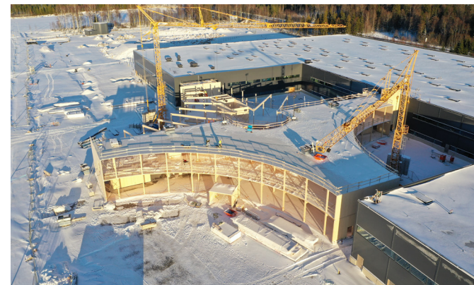
Etapp 3 - Kontorsbyggnad. Bild från vintern 2023.
